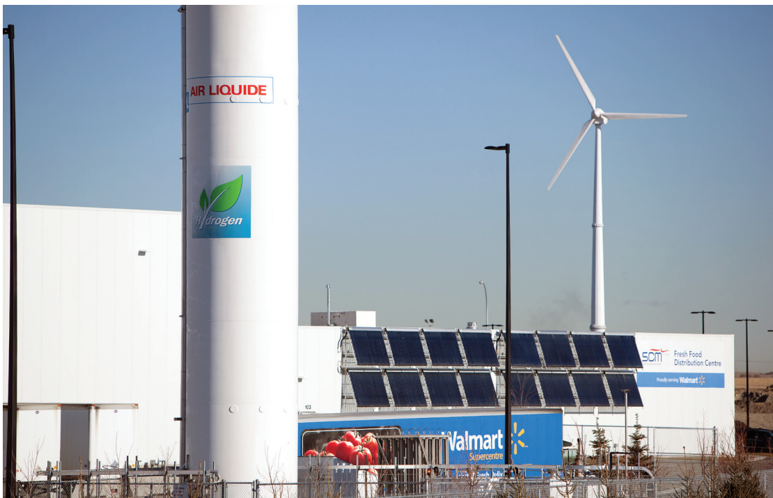
Fig. 25. Balzac Fresh Food Distribution Center (Walmart), Canada
